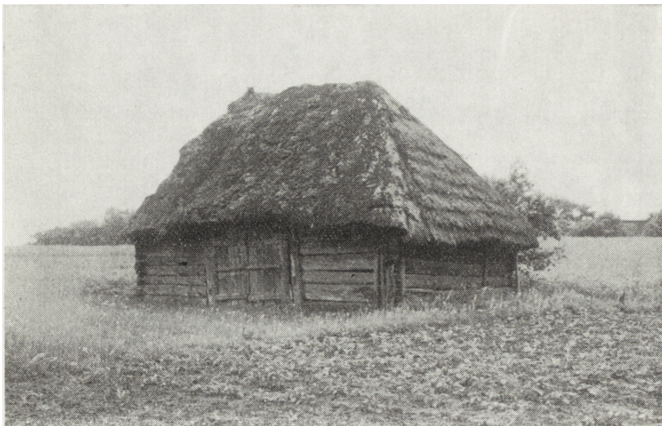
Ryc. 21. Rokitno — Kopaliny, nr 152. Stodoła na planie zbliżonym do kwadratu, budowana ok. 1870 roku
