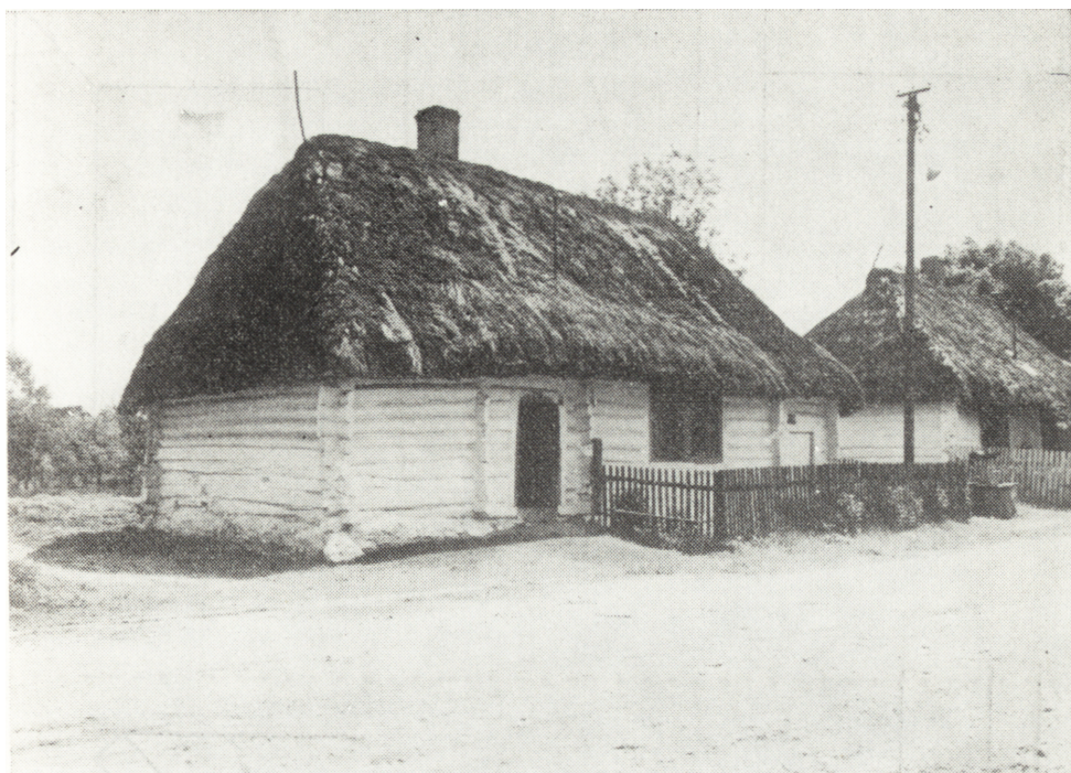
Ryc. 12. Rokitno — Krakówka, nr 7. Dom mieszkalno-inwentarski, budowany w 2 połowie XIX w.
