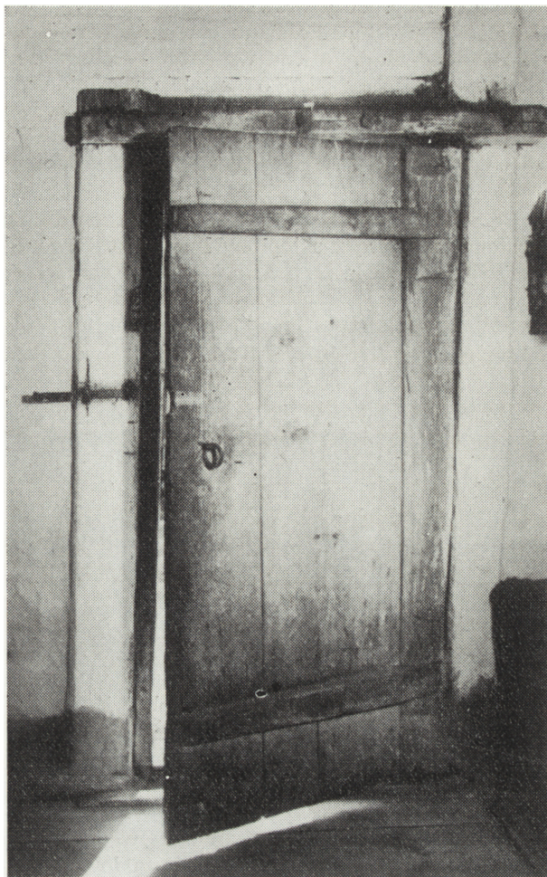
Ryc. 17. Rokitno — Szafranka, nr 8. Drzwi zawieszane na kołowrocie w domu budowanym w 1869 r.
