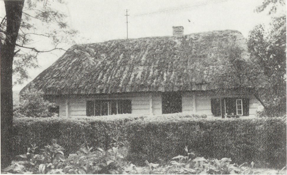
Ryc. 20. Rokitno — Stara Wieś, nr 39. Dom mieszkalny dwuizbowy, pochodzący z 1870 roku
