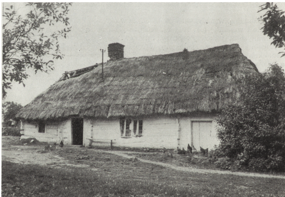
Ryc. 10. Rokitno — Podkaszczor, nr 88. Budynek mieszkalno-inwentarski stawiany ok. 1800 roku
