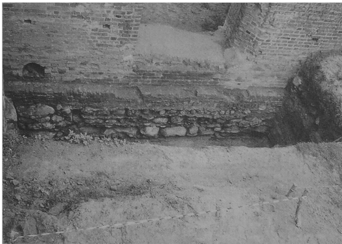
Fot. 4. Fundament bramy wiślanej z widocznymi otworami kanałów odpływowych – widok od północy (fot. L. Kotlewski)
