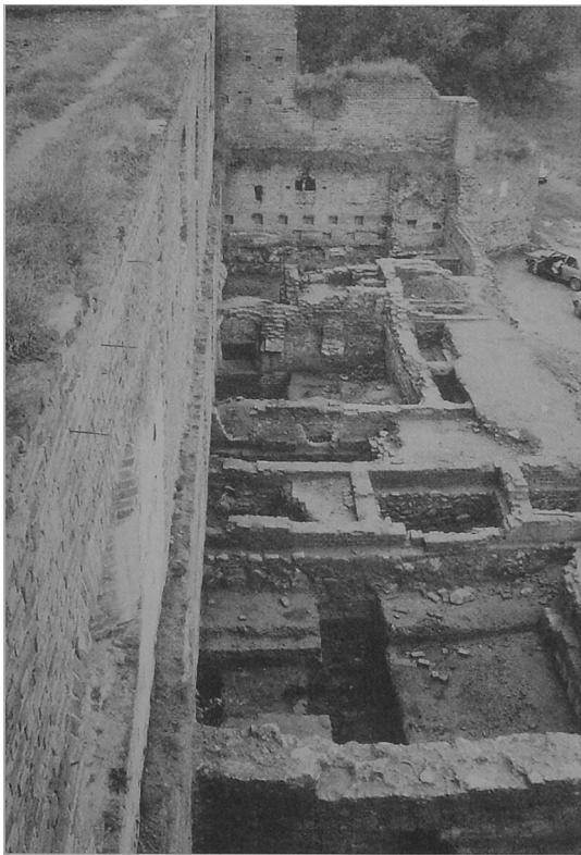
Fot. 1. Odślonięte mury części mieszkalnej – widok od wschodu (fot. L. Kotlewski)
