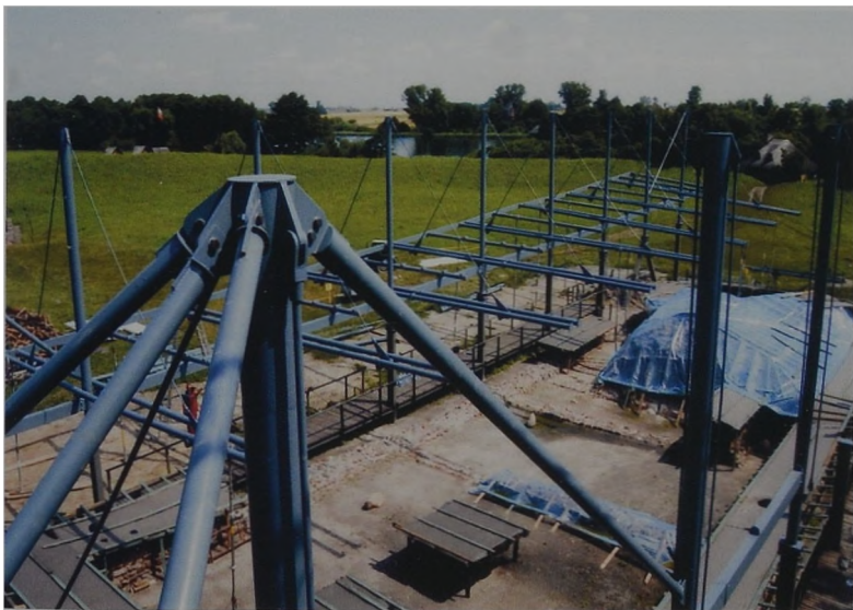
Fot. 2 Prace przy montażu nowej osłony (fot. A. Ziółkowski) Photo 2. Arbeiten bei der Montage des neuen Schutzes (Photo: A. Ziółkowski)
