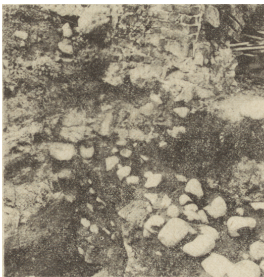
Ryc. 14. Łęczyca, poprawki z 1563 r. w fundamencie „domu starego”
