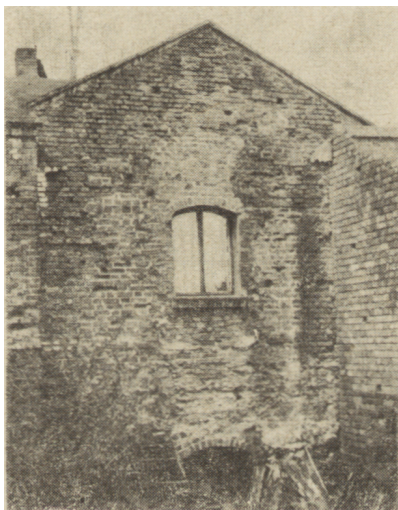
Ryc. 13. Łęczyca, południowa ściana „prochowni” czyli dawna ściana sieni „domu starego” (widoczne kamienie progu dawnego otworu drzwiowego)
