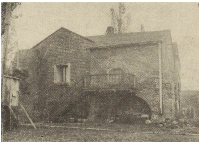
Ryc. 6. Łęczyca, elewacja północna „prochowni” (fot. A. Kaczmarek)
