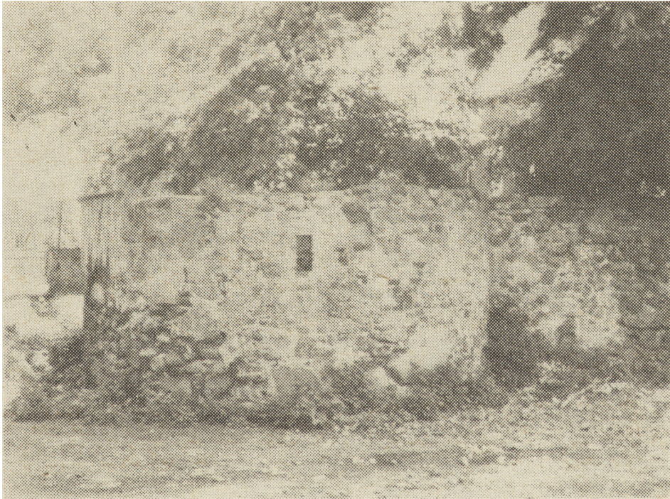
Ryc. 24. Lutynia. Mur przykościelny, bastcja północno-zachodnia. Widok od W. Fot. Tadeusz Poklewski
