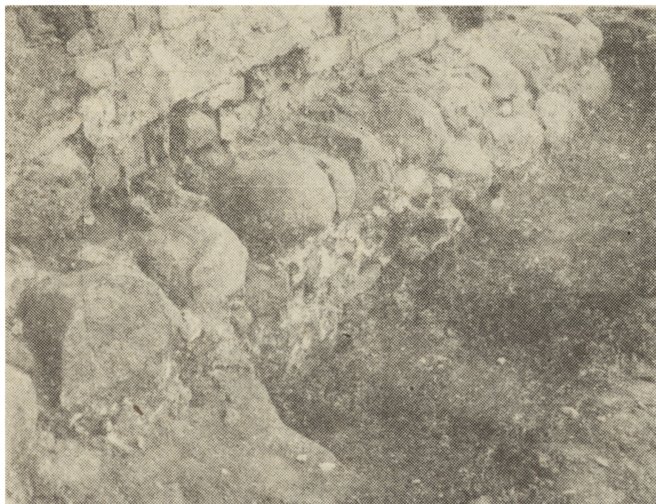
Ryc. 15. Międzybórz. Ława fundamentowa zachodniego skrzydła reliktu muru obronnego. Widok od NW, z zewnątrz. Fot. Tadeusz Poklewski
