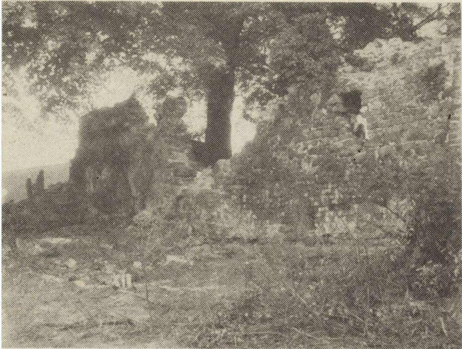
Ryc. 6. Międzybórz. Zachodnie skrzydło reliktu przykościelnego muru obronnego z basteją. Widok od SW, z zewnątrz. Fot. Tadeusz Poklewski
