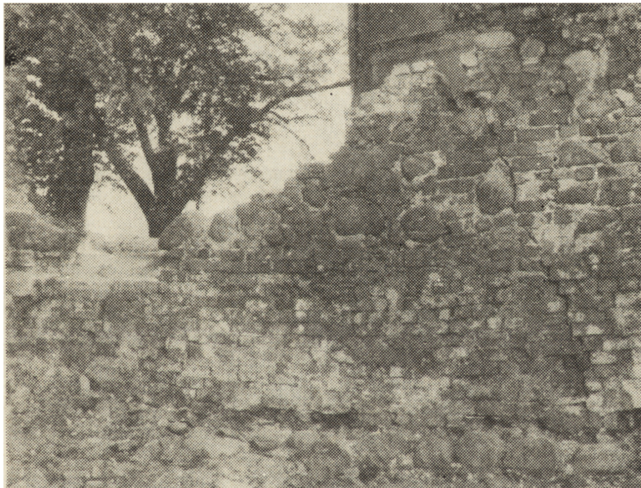
Ryc. 14. Międzybórz. Wątek licowy na zewnętrznej powierzchni skrzydła zachodniego. Widok od W. Fot. Tadeusz Poklewski
