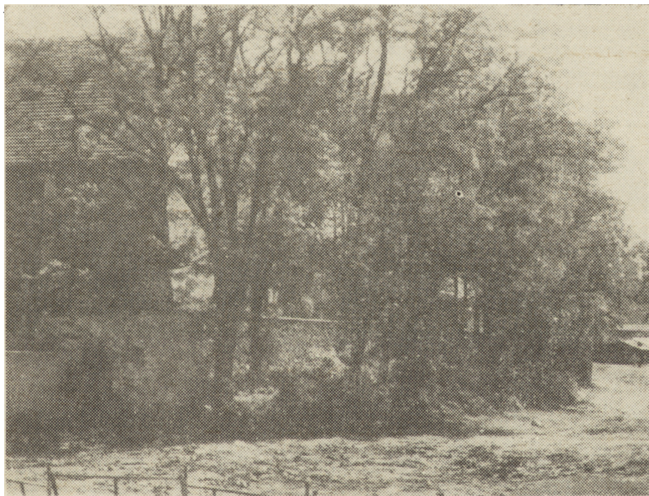
Ryc. 28. Źródła. Mur obronny przykościelny, kurtyna zachodnia z bastejami. Widok od NW. Fot. Tadeusz Poklewski
