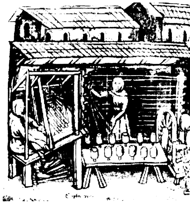
Ryc. 26. Snowadła nieruchome i krosno wielonicielnicowe z manuskryptu Historia ordinis humiliatorum z 1421 r. (wg K. Tidowa).
