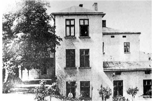
Ryc. 4. Nowe skrzydło głównego pawilonu
