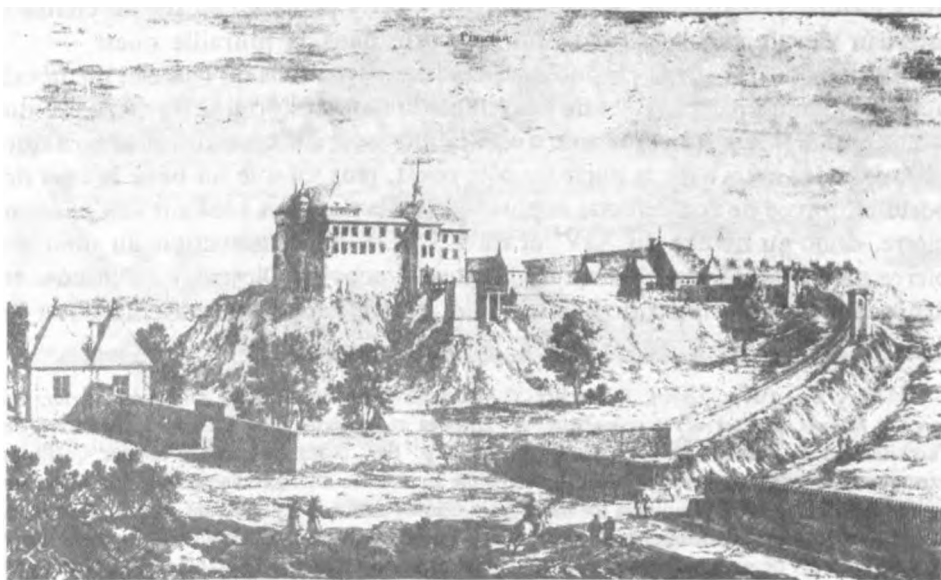
Fig. 3. Pińczów. Château – on voit le pont basé sur d'énormes piliers bâtis en pierre
