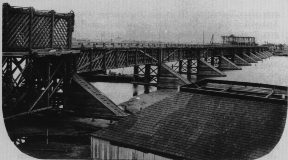
Widok Mostu tymczasowego zdjęty z Nowego Zjazdu od strony prawej d. 2 Października 1860. r.
