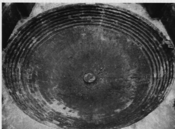
2. Odkopany fundament wieży i rysunek z projektu Józefa Orłowskiego z 1870 r. Widoczny potężny fundament z centralną formą odwróconej kopuły
