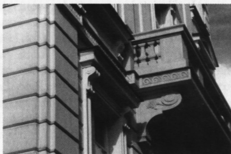
8. Odnalezione fragmenty fryzu kordonowego i tralek balkonowych, których formę powtórzono przy rekonstruowaniu fasady
