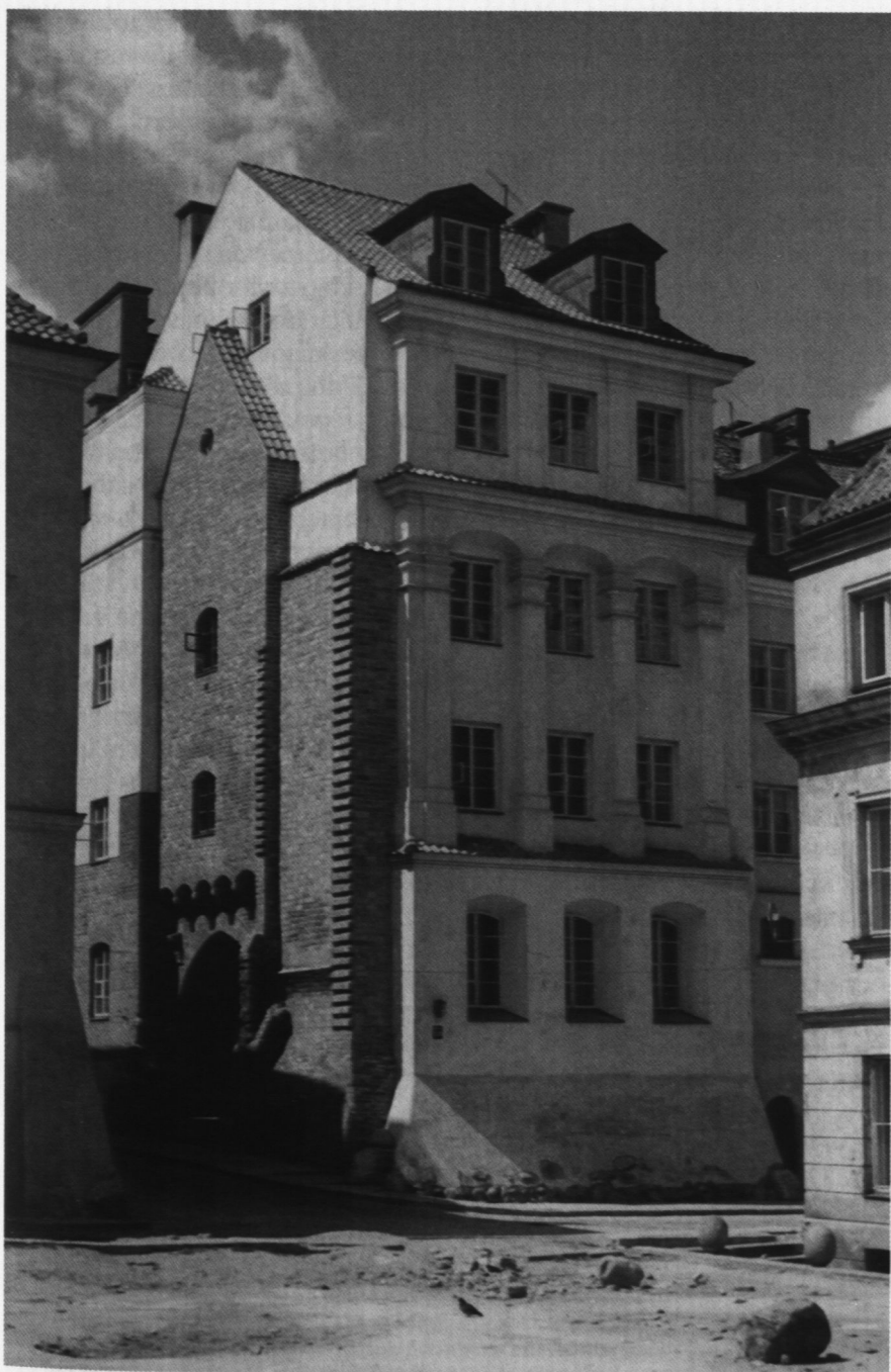
6. Zabudowa tylnej części parceli Bornbachów z odsłoniętą elewacją frontową spichlerza gotyckiego, po 1960 r.
