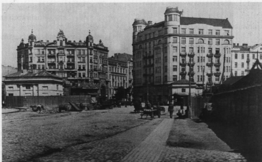
4. Rondo Mokotowskie – widok od ulicy Nowoaleksandryjskiej (obecnie Puławskiej), po obu stronach zabudowania stacji kolejek dojazdowych
