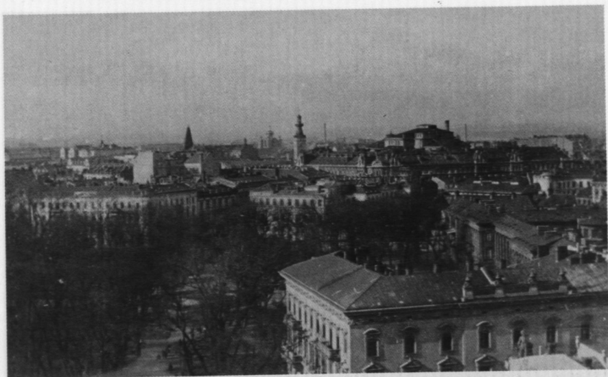
11. Panorama Śródmieścia z latarni kościoła ewangelickiego – widok w kierunku północnym, marzec 1916 r.
