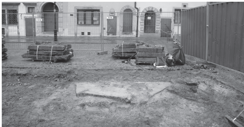
Fot. 3. Rynek Starego Miasta w Warszawie. Południowa część fundamentu kuny
