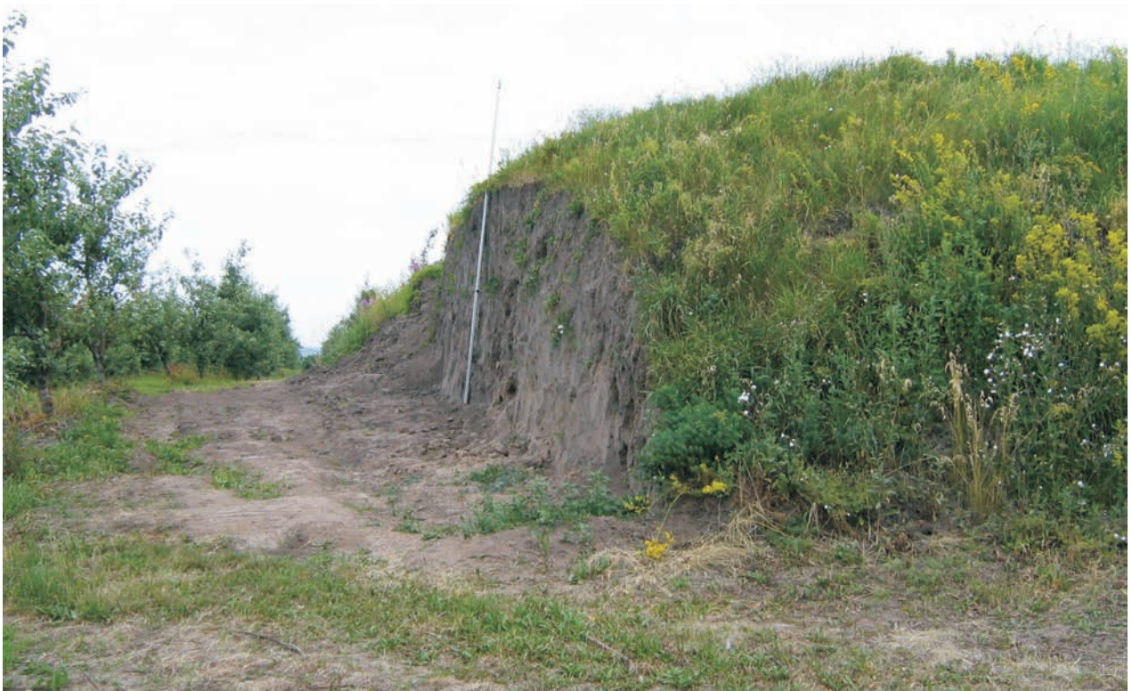
Ryc. 3. Świącica, pow. sandomierski, stan. 1. Widok od SW na zniszczoną, zachodnią część nasypu kopca (czerwiec 2005 r.). Fot. M. Florek.
