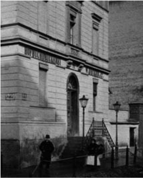
Wejście główne do budynku
