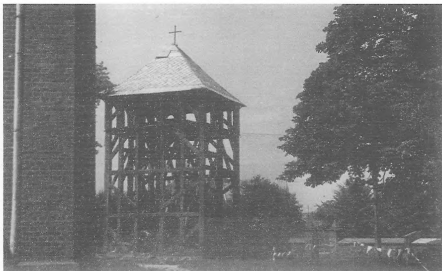
U góry: Dzwonnica podczas remontu w 1977 r.
