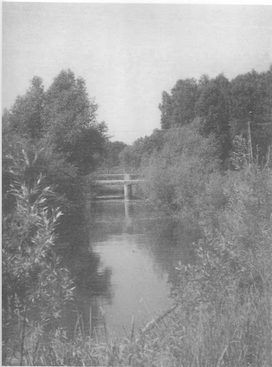
Biezuń. Jaz z mostem do pałacu. Fot. S. Ilski, 1999 r.
