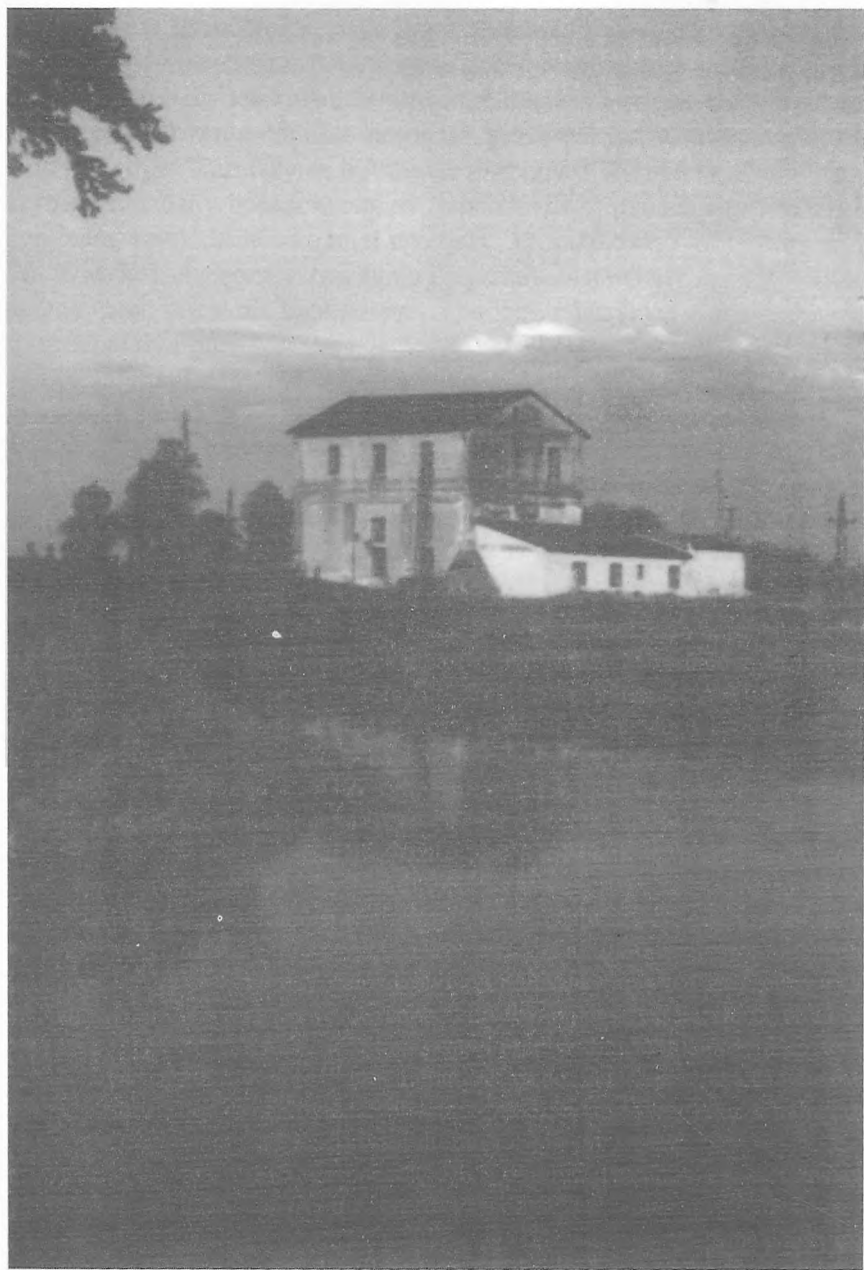
Zbiornik wody przy młynie. Fot. Z. Dobrowolski, ok. 1966 r.
