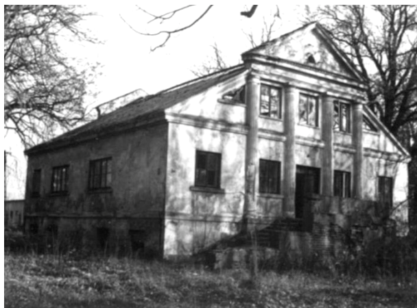
Fot. 2. Zabytkowy budynek oficyny dworskiej z połowy XIX w. w sołectwie Prusinowice
