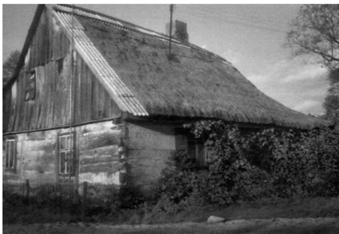
Fot. 4. Jeden z ostatnich przymłyńskich budynków mieszkalnych w regionie (Ruda Jeżewska)
