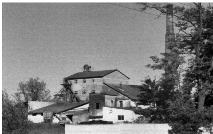
Fot. 1. Prusinowice. Dawny młyn elektryczny w kompleksie gorzelnicznym Źródło: R. Kucharski, Młyny jako element zagospodarowania ...
