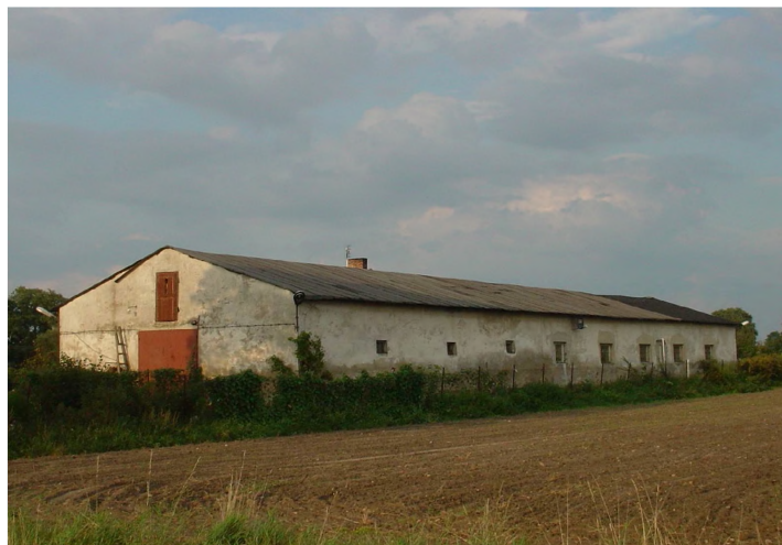
Fot. 1. Folwark w Kotlinach 2007 r. Źródło: D. Klemantowicz
