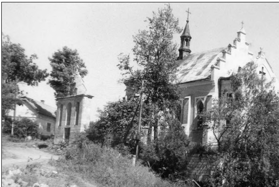
Fot. 13. Kościół w Nowosiółce (stan z sierpnia 1990 r., wcześniej wykorzystywany jako sala gimnastyczna)
