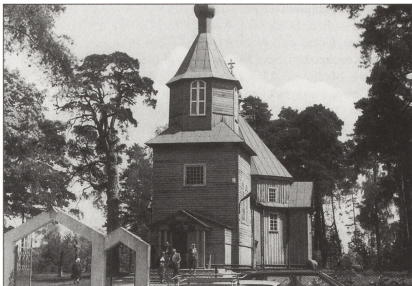
Cerkiew Św. Antoniego Pieczerskiego w Kuraszewie
