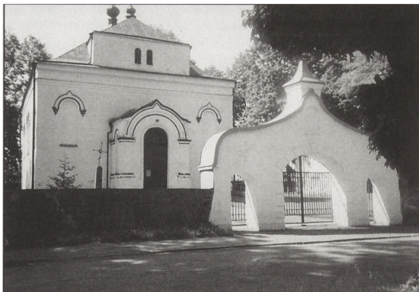
Cerkiew pw. Zaśnięcia Najświętszej Marii Panny w Boćkach
