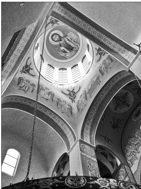
Il. 39. Cerkiew Opieki Matki Bożej w Bielsku Podlaskim. Widok kopuły i konstrukcji bębna podkopułowego na 4 pendentywach i 4 filarach nośnych z łukami półtorusoidalnymi. Fot. autora
