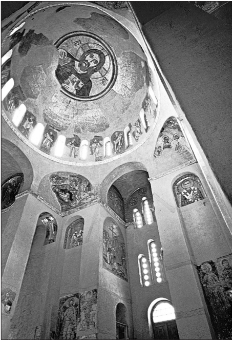
Il. 24. Cerkiew-katolikon Manasteru Daphni. Kopuła na trompach narożnych z mozaiką Pantokratora (XII w.). Fot. autora
