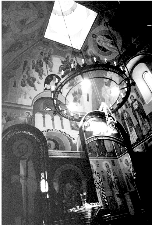
Il. 44. Cerkiew Świętej Trójcy w Bielsku Podlaskim. Widok struktury przestrzennej wnętrza: kopuły, bębna podkopułowego na 4 pendentywach i sklepieniu klasztorным. Fot. autora
