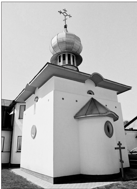
Il. 43. Cerkiew Świętej Trójcy przy Studium Ikonograficznym w Bielsku Podlaskim (2000–2004, arch. J. Uścińowicz; ikonog. ks. mitr. L. Tofiluk z zespołem studentów). Świątynia salowa, jednokopułowa. Widok zewnętrzny od strony wschodniej. Kopuła na bębnie przeszklonym z nośną konstrukcją stalową wewnątrz. Fot. autora
