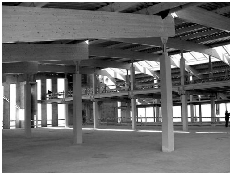
Fot. 7 Konstrukcja budynku, czytelnia na 2 piętrze
