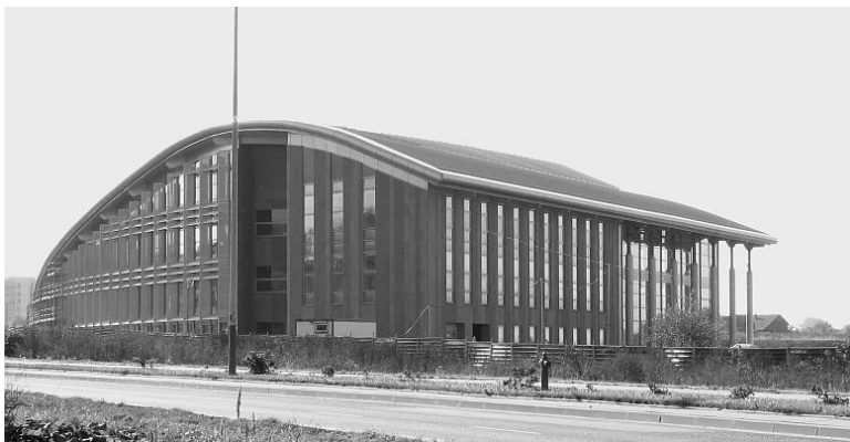
Fot. 5 Budynek biblioteki o strony ul. Bobrzyńskiego
