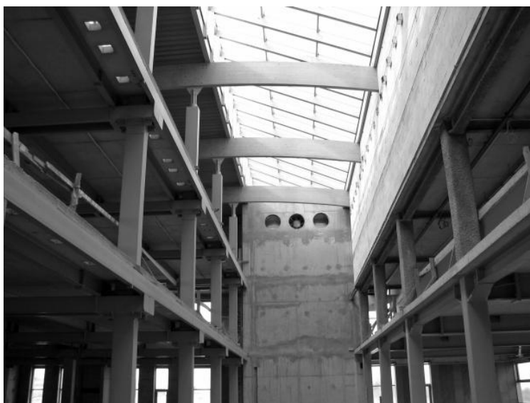
Fot. 8 Konstrukcja budynku
