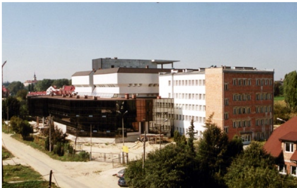
Budowa Regionalnej Biblioteki Akademickiej, wrzesień 1998
