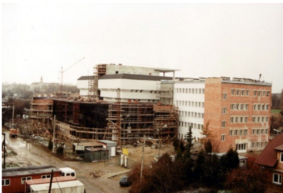
Budowa Regionalnej Biblioteki Akademickiej, czerwiec 1997
