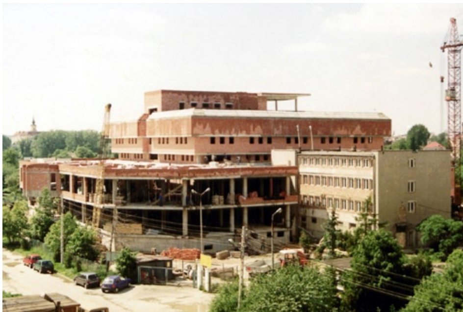
Budowa Regionalnej Biblioteki Akademickiej, kwiecień 1996
