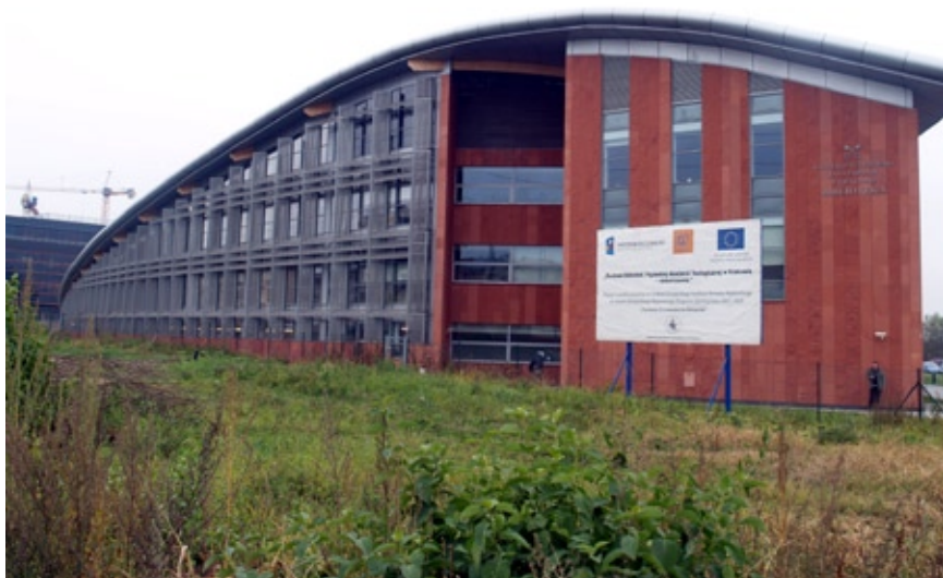
Widok budynku od strony południowo-wschodniej
