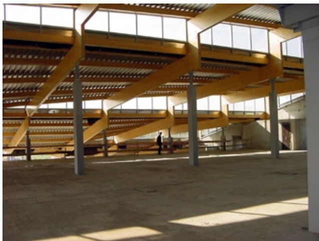
Konstrukcja dachu budynku
