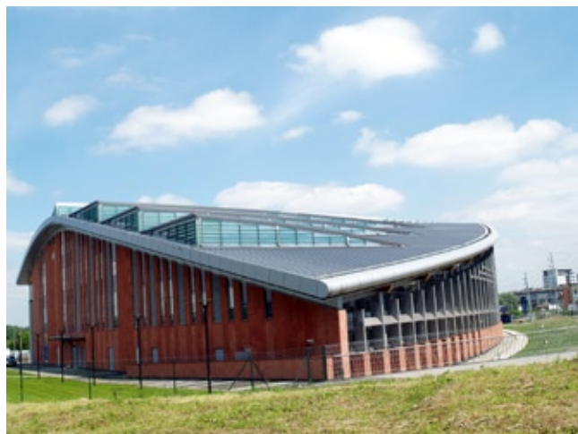
Widok budynku od strony południowo-zachodniej
