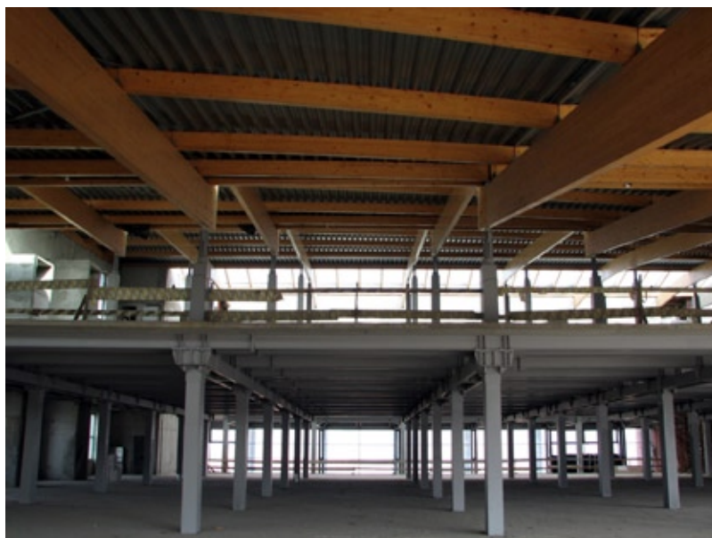
Konstrukcja stalowa budynku – stan surowy*
