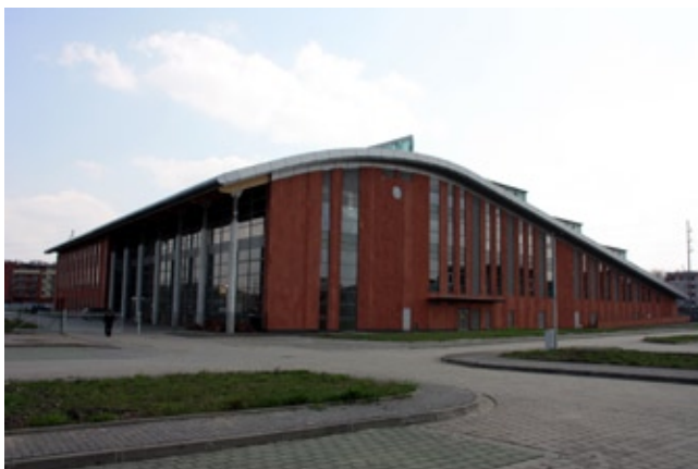
Widok budynku od strony północno-zachodniej
