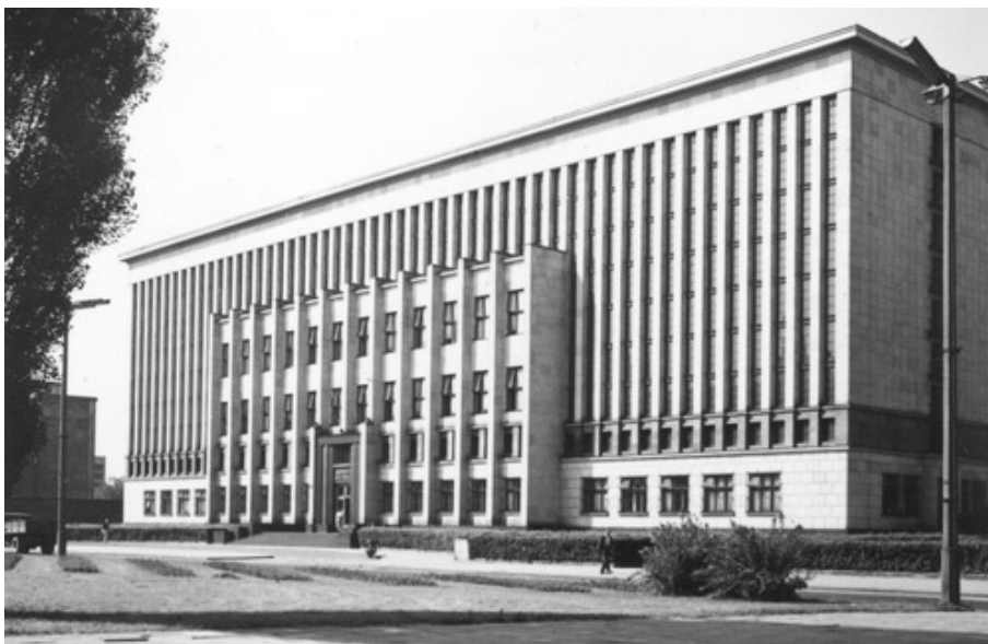
Budynek Biblioteki Jagiellońskiej wybudowany w latach 1931-1939 wg projektu W. Krzyżanowskiego
