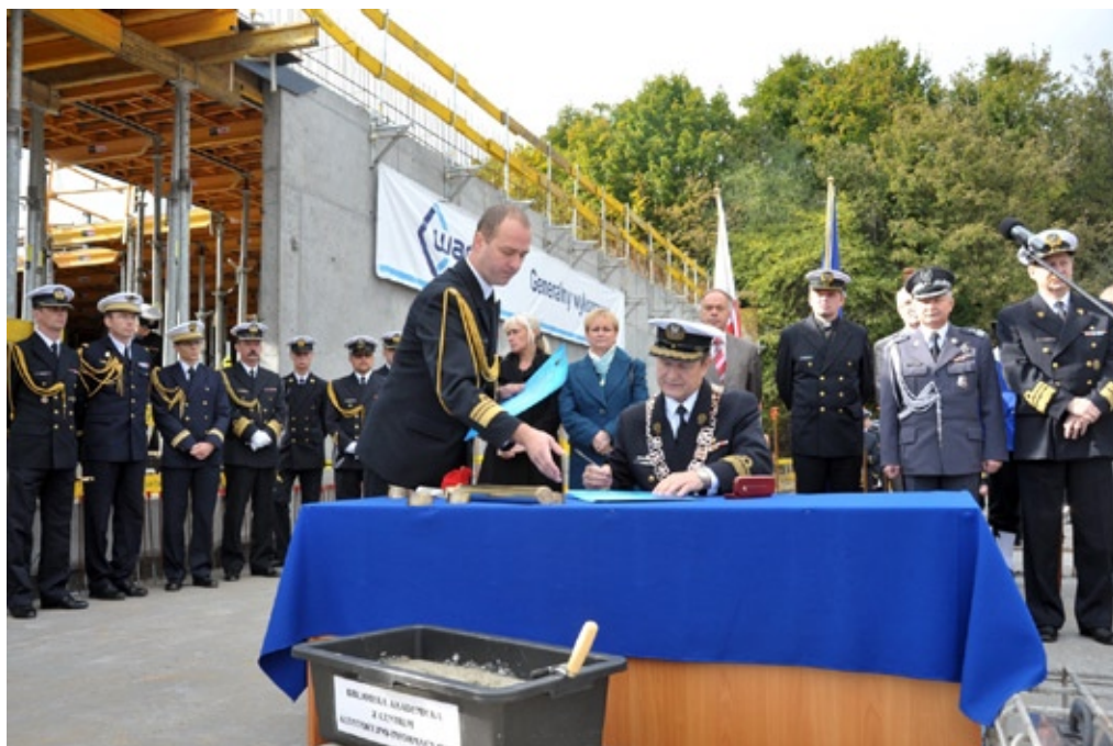
Uroczyste wkopanie kamienia węgielnego pod budowę Biblioteki w 2010 roku (fot. Krzysztof Miłosz)
