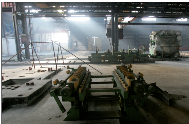
Fot. 15. Nieczynna hala Huty Jedność w Siemianowicach Śląskich (fot. Arkadiusz Gola)
