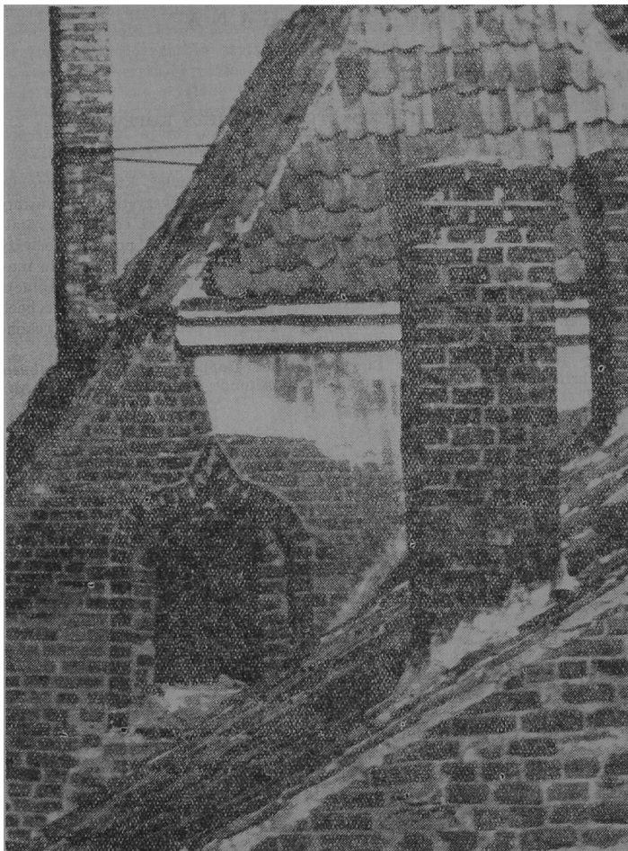
Ryc. 2. Jedna z kurii w obrębie dziedzińca katedralnego w Fromborku, w sąsiedztwie Wieży Kopernika. Przykład zachowanego do dzisiaj okna gotyckiego w formie „oślego grzbietu”
