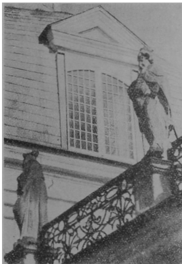
Ryc. 4. Św. Lipka. Krata na płaskim dachu frontowej kolumnady dziedzica wykonana przez kowala Zeloffa z Fromborka w 1744 r.
