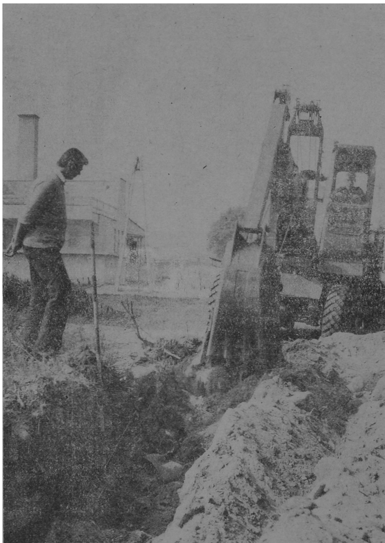
DĄBRÓWNO 1980; KOPARKA ODŚLANIA FRAGMENT MURU OBRONNEGO
