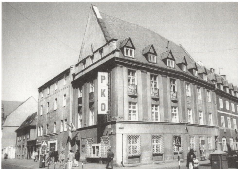
3. Blok mieszkalny przy ulicy Rzeźnickiej (Słowackiego nr 42). Stan z 1996 r.
