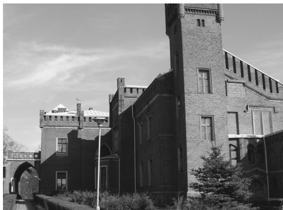
1. Pałac – elewacja od strony dziedzińca (fot. M. Dąbkowska)
