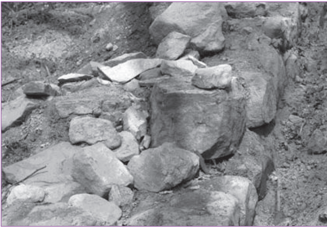
2. Krajowice. Relikty zamku Golesz. Kamienie wybrane ze zniszczonej w kopaniach podziemnej partii murów i złożone na koronie oryginalnego muru zamkowego, kwiecień 2009. Fot. I. Malawska.
