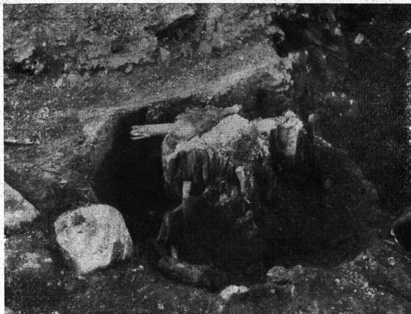
Rys. 3. Fragment konstrukcji młota na polanie Stare Kościeliska. Nabijany klinami pień stanowi odbój trzonka młota (nr 4).
