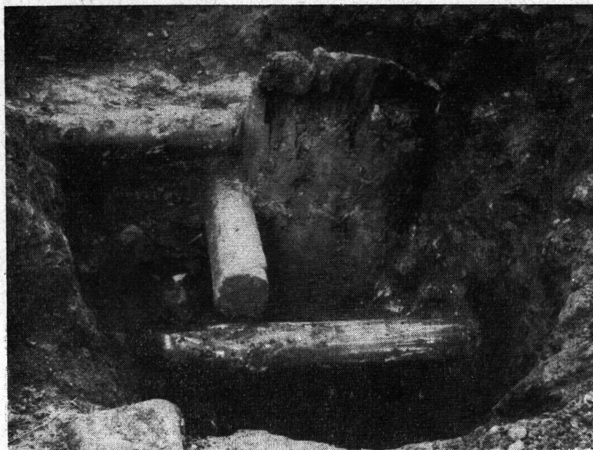
Rys. 2. Fragment konstrukcji młota w hucie na polanie Stare Kościeliska. Pień służy za podstawę pod kowadło (nr 6)
