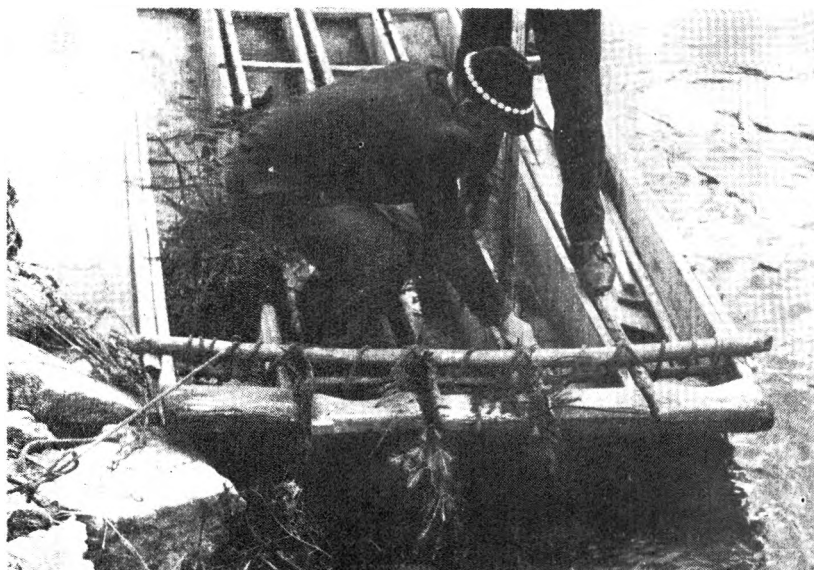
Ryc. 12 i 13. Szczeliny między łodziami są obtykane drobno ciętymi gałązkami czyli „cetyną”; na dolnym zdjęciu widoczna żerdź do ubijania uszczelnienia
