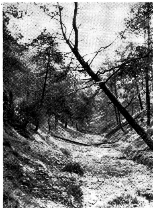
Ryc. 5. Ślady kanału odkrytego, tzw. roznosu sztolni Ponikowskiej w Hutkach około Olkusza, zbudowanej w XVI w., a odnowionej w końcu XIX w. (Fot. Aleksander Saładziak)
