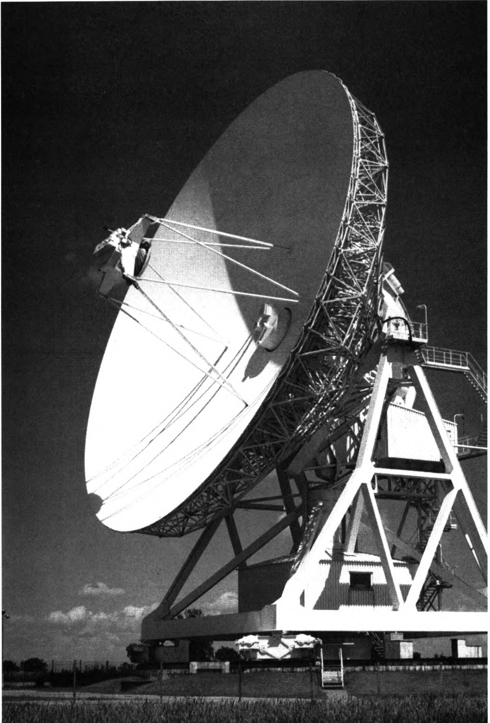
Ryc. 1 Radioteleskop RT-4, D = 32 m.
