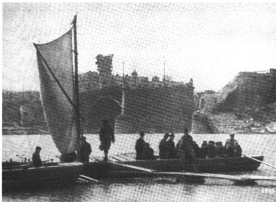
Rys. 15: BATY na przewozie przy praskim brzegu w Warszawie. Na drugim planie ocalałe przęsło i przyczółek Mostu Ks. J. Poniatowskiego. Komunikacja z lądem po prymitywnych pomostach. Wiosna 1945. Aut. fot. nn.
