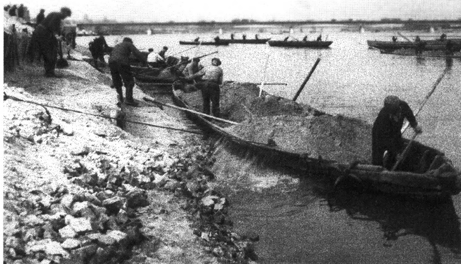
Rys. 9: BAT wyładowujący urobek piasku w km 513 rz. Wisły. Na dziobie piaskarz „wychlapujący” wodę zęzową. Na drugim planie baty wydobywające piasek. W tle Most Śląsko-Dąbrowski; z lewej słabo widoczna wieża kościoła NMP na Nowym Mieście. Reprod. starej fotografii z końca lat czterdziestych. Aut. nn.
