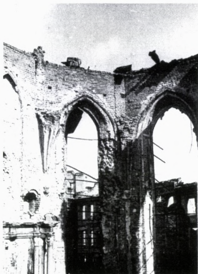
Fot.20. Katedra św.Jana, widziana z wznoszącej się wewnątrz góry gruzów. Warszawa była zburzona, ludzie z jej ruin wypędzeni. W powietrzu unosił się charakterystyczny, gryzący zapach pyłu zwalonych murów.
