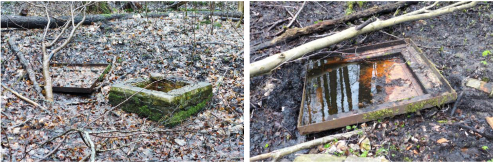
Ryc. 9. Studnia drenażowa nr 5; widoczna jedyna zachowana, oryginalna pokrywa o nitowanej, stalowej konstrukcji, obecnie w depozycie Urzędu Miasta Wejherowo (fot. M. Klugmann)
