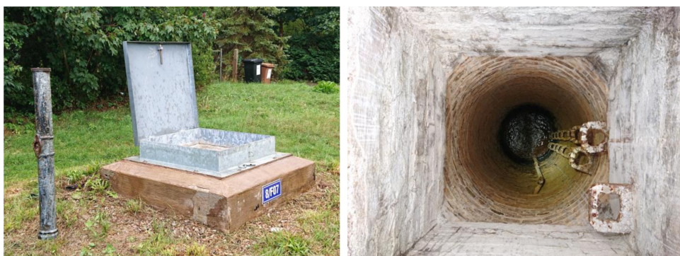
Ryc. 12. Porównanie ze studnią ujęcia Polanki (1878 r.); studnia ta podlega konserwacji, ponieważ drenaż ujęcia stanowi odwodnienie terenów przy ul. Abrahama w Gdańsku (fot. M. Klugmann)
