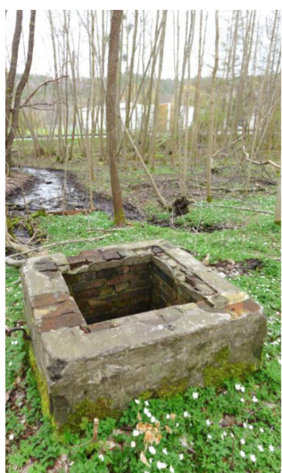
Ryc. 7. Studnia drenażowa nr 1 (fot. M. Klugmann)
