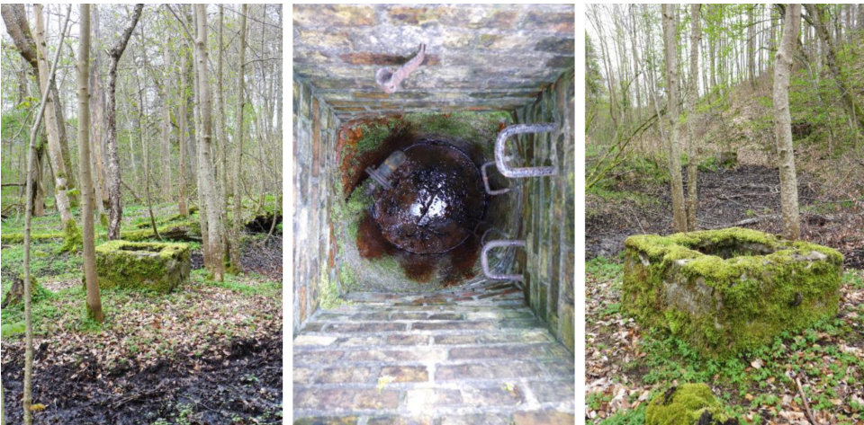
Ryc. 10. Studnia drenażowa nr 6; widać fragment rurociągu i uchwyt – pozostałość pokrętła zasuw, odcinającej połączenie ze studnią nr 7 (fot. M. Klugmann)
