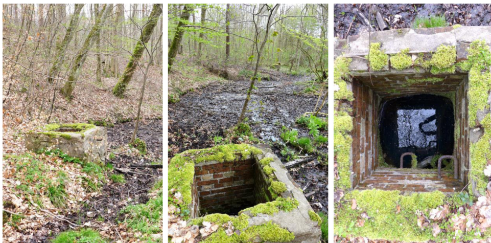
Ryc. 11. Studnia drenażowa nr 7 (fot. M. Klugmann)
