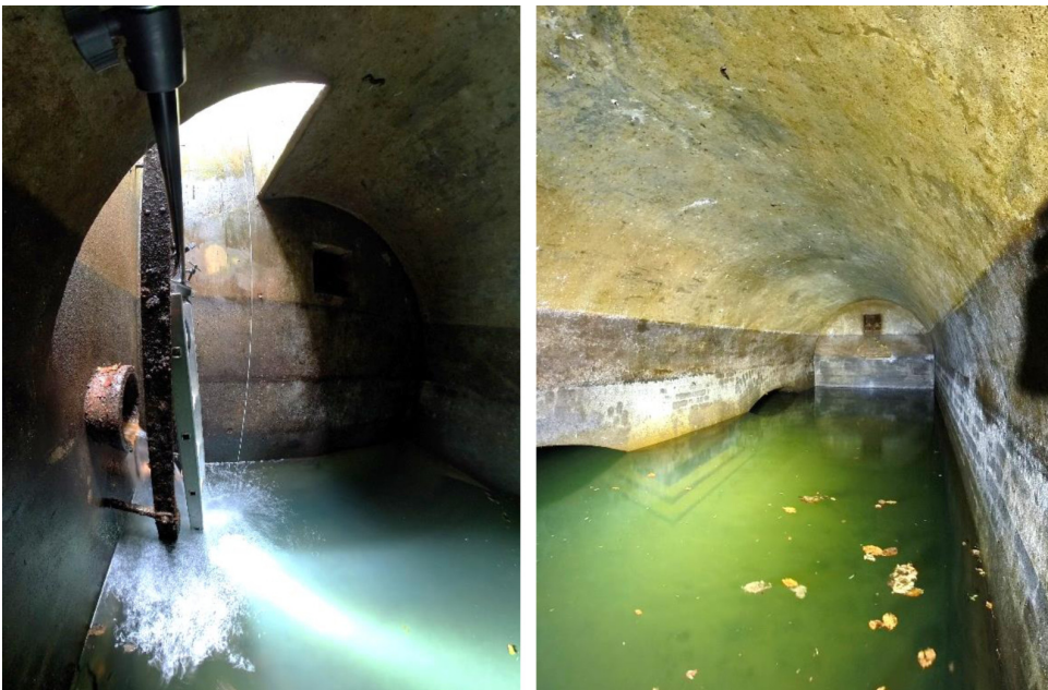
Ryc. 15. Wnętrze zbiornika (dostępnej nawy); z lewej – szyb wejściowy, oryginalna drabina i końcówka rurociągu dopływowego za drabiną, otwór wentylacyjny w ścianie; z prawej – górne fragmenty arkad nad powierzchnią wody i widoczna baza kolumny pod wodą, w głębi – drugi otwór wentylacyjny (fot. M. Klugmann)
