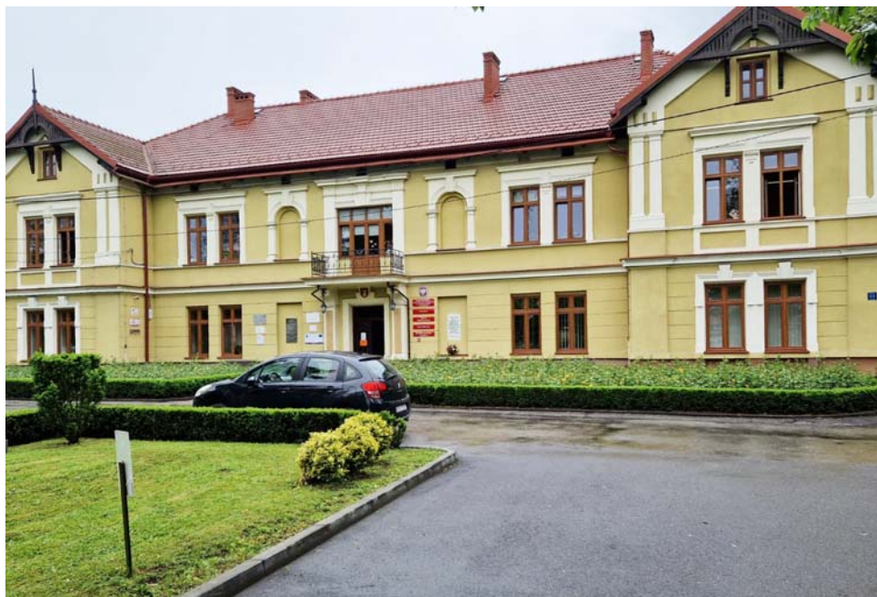
Ryc. 3. Szkoła Rolnicza w Czernichowie. Budynek główny. Stan obecny (fot. J. Piskurewicz)
