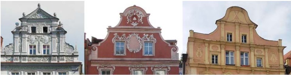
Ryc. 5. Szczyty kryjące niższe dachy o spadku: a. ok. 50° przebudowanej po pożarze z 1694 r. kamienicy przy Rynku nr 20 w Bytomiu Odrzańskim (odbudowa powojenna); b. ok. 45° domu Franza Antona Sebastianiego przy rynku w Głogówku pod nr 25 z lat 1770–1780; c. ok. 30° przy Rynku pod nr 4 w Łądku Zdroju z ok. połowy XVIII w (fotografie autorki)
