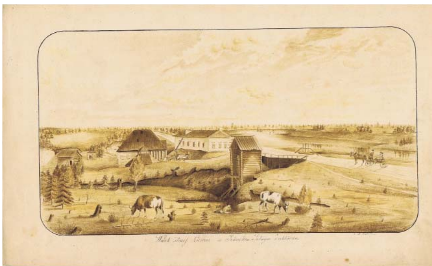
Widok Starej Giserni w Irkuckim Solnym Zakładzie
