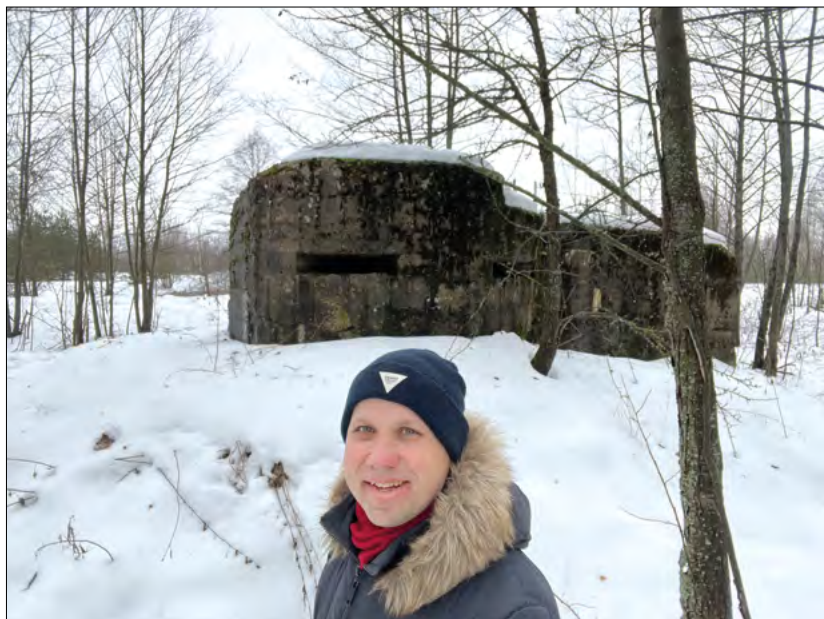
Autor na tle niemieckiego schronu obok kanału Ogińskiego
