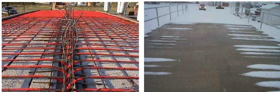
Rys. 2.3. Most w Weatherford, z lewej instalacja rozmrażania w trakcie budowy, z prawej efekt działania instalacji
