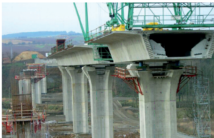
Rys. 3.2. Most skrzynkowy
