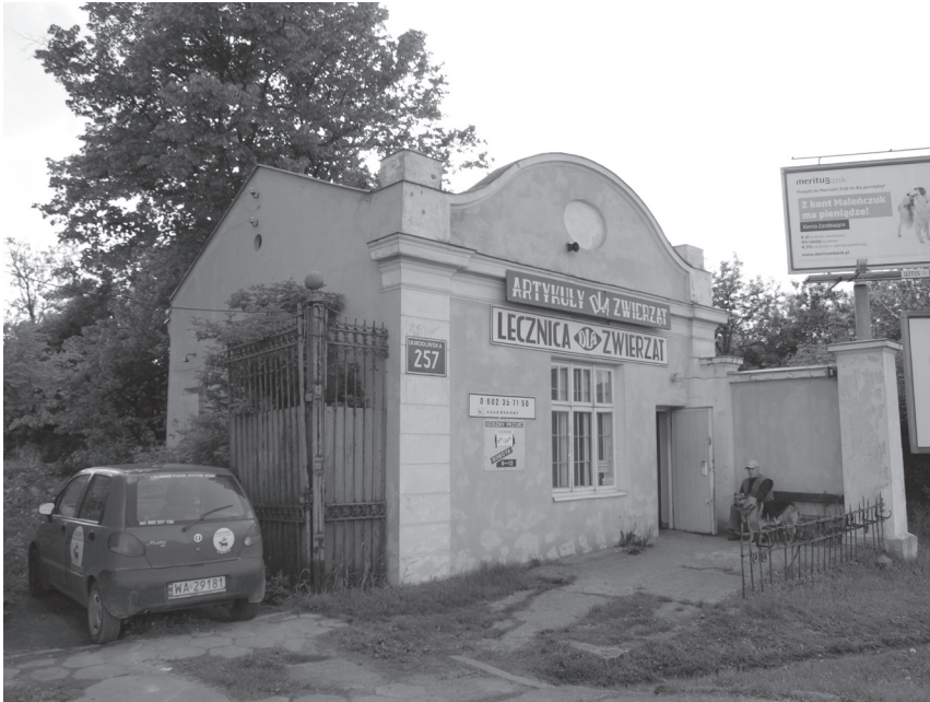
Henryków, oficyna secesyjnej kamienicy, ul. Modlińska 257, Fot. M. Bryk
