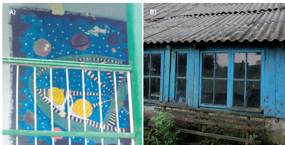
Ryc. 17. A) Dekoracje na elewacji domu pionierów; B) Typowe pokrycie dachu eternitem
