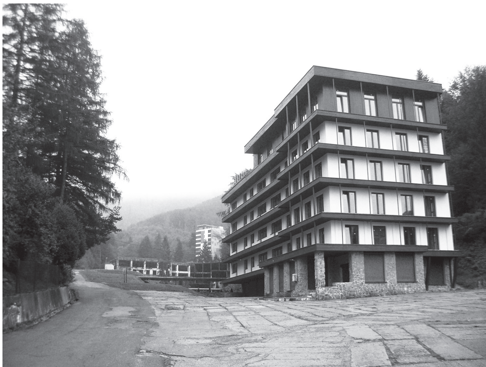
Ryc. 3. Kozubnik-Porąbka, Ośrodek wypoczynkowy Hutniczego Przedsiębiorstwa Remontowego
